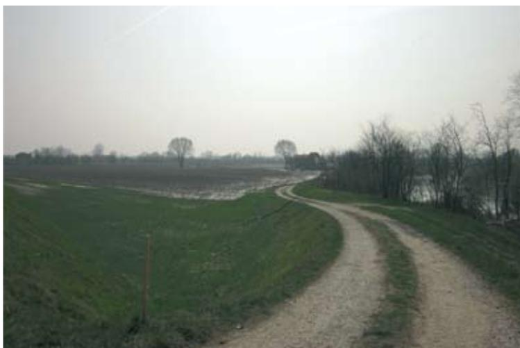
te limitata. Da segnalare che durante gli eventi di piena che causano la sommersione dell'area si verificano dei fontanazzi alla base del piede dell'argine. Per la risoluzione del problema sono state effettuate alcune diaframature lungo l'argine.
